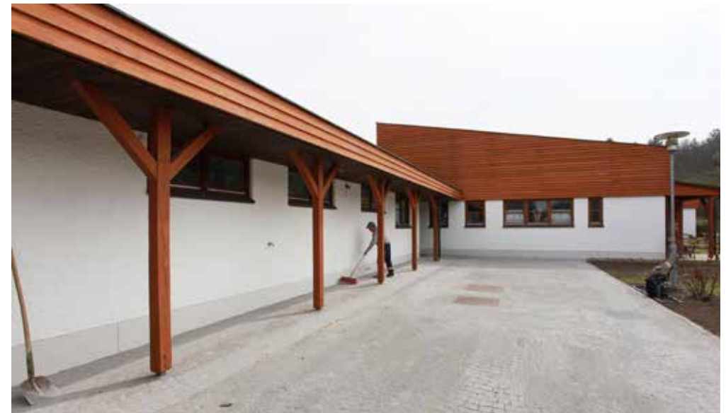
Seite 6: Oben Fassade „Fischerhaus“; unten Fassade „Getränkelerager“ Seite 7: Oben Gang „neuer Belag“; unten „Eingang Pflaster“
